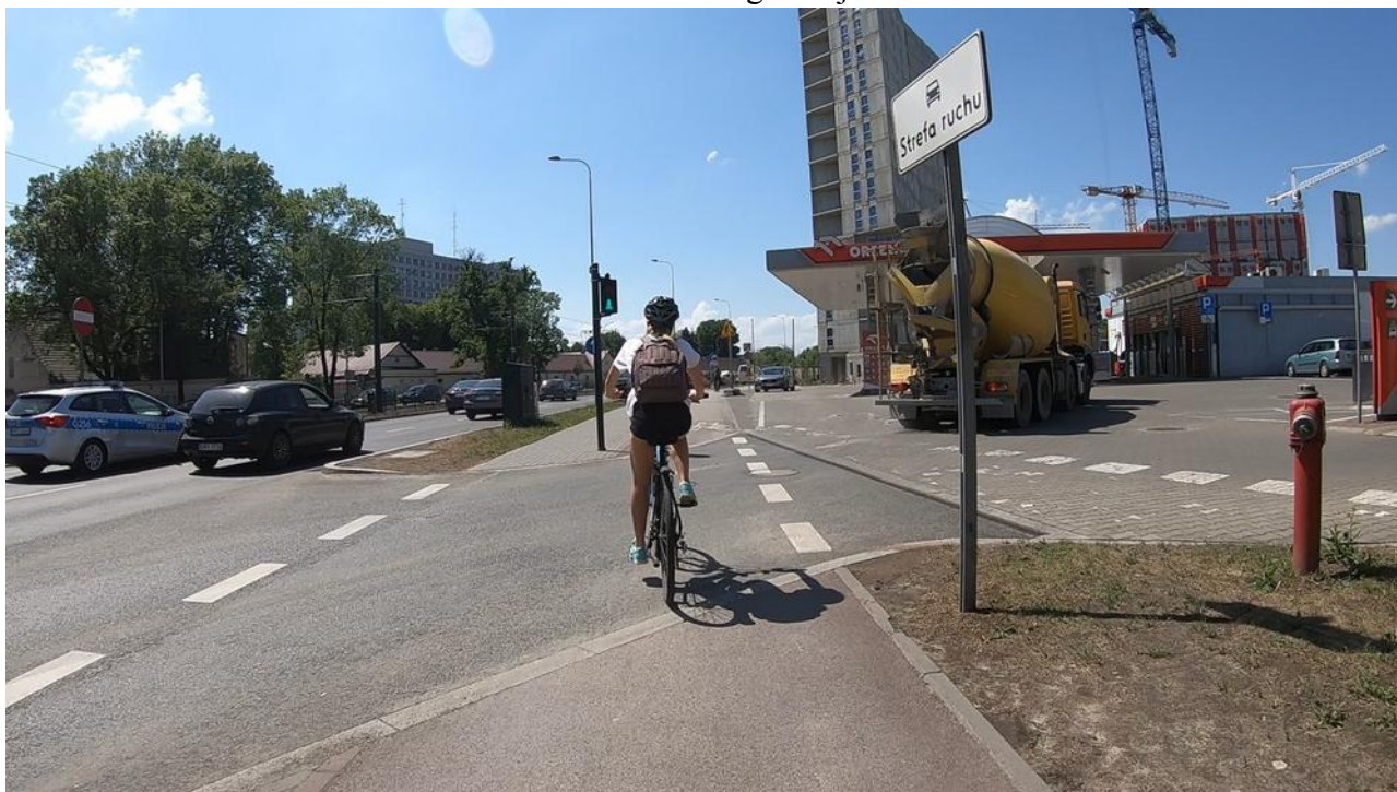
Fot.1 – brak oznakowania w osi DDR wzdłuż ul. Mogilskiej
